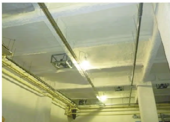
倉庫 RC下地 天井
