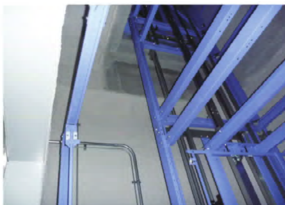
エレベーターシャフト内 RC下地 壁
